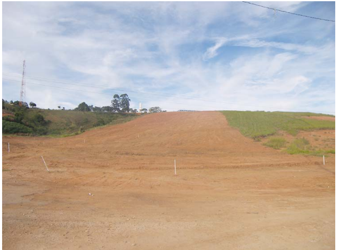
Serviços de terraplanagem.
